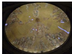
Eflorescencias salinas en el interior de la basílica, asociada a humedades
