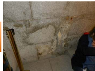
Eflorescencias salinas en el interior de la basílica, asociada a humedades
